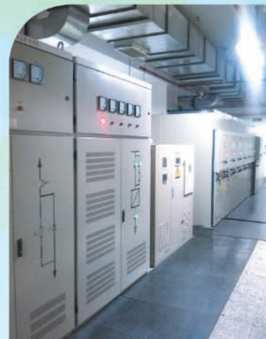
北京10号线草桥线逆变装置
