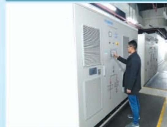
成都7号线琉璃场站
