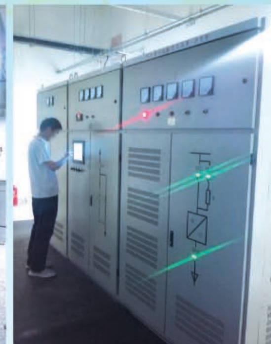
北京10号线丰台站逆变装置
