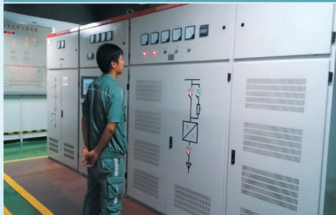
重庆6号线会展支线礼嘉站逆变装置
