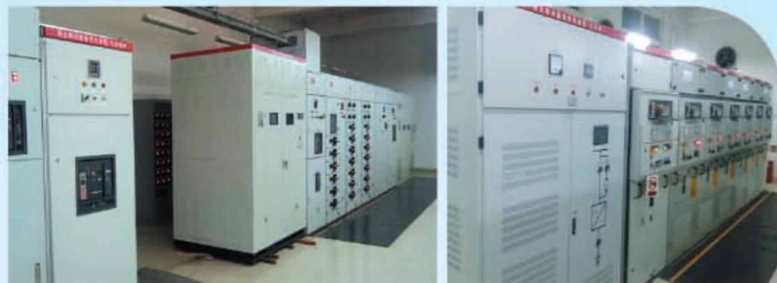
南京1号线安德门站变压器柜、开关柜
